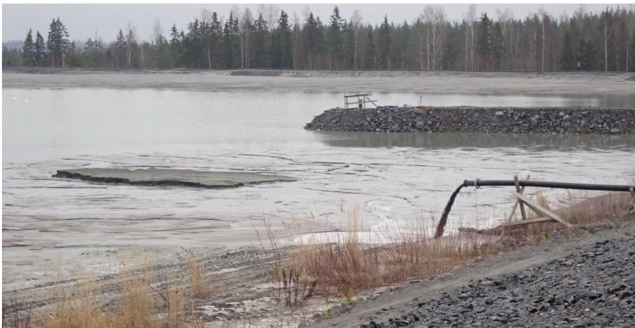
Rikastushiekan läjitystä B-altaalle spigotointi-menetelmällä. Kuvattuna välipadolta.
